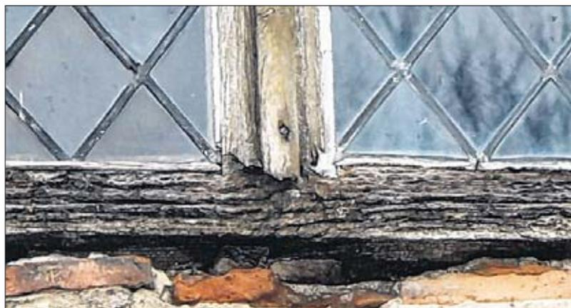
Angefressen vom Zahn der Zeit: Die hölzernen Fenster-Konstruktionen sind sichtbar beschädigt.
